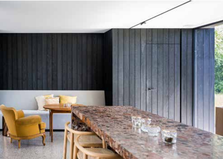
Zowel de gevel van de woning als de aanbouw zijn uitgevoerd in gebrand thermisch essen.
