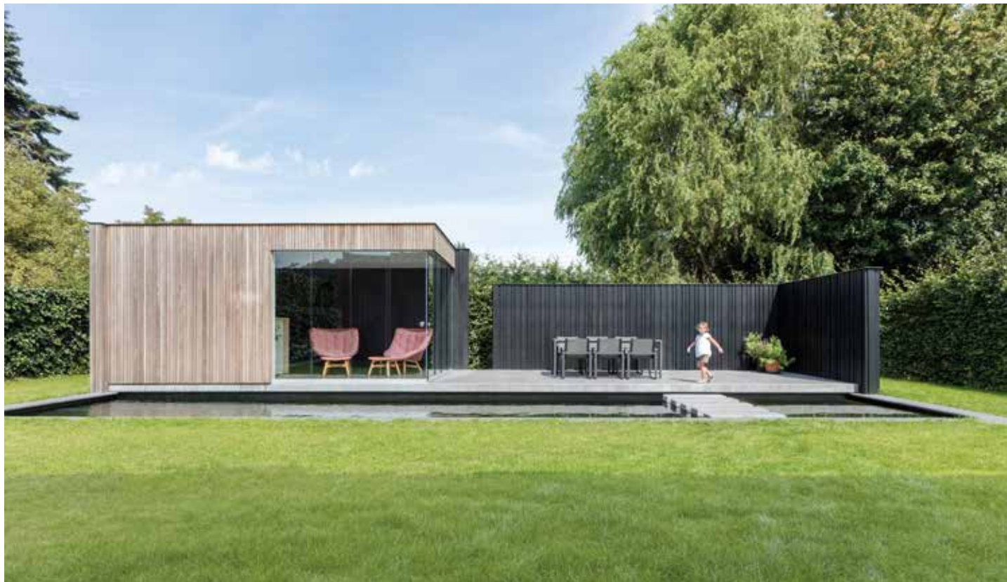
Deze minimalistische moderne poolhouse ligt letterlijk aan de zwembijver en nodigt uit tot relaxen. De verzonken schuiframen op de hoek bieden een maximaal zicht. Samen met de doorgetrokken betonvloer zorgen ze voor een naadloze overgang tussen de binnen- en buitenruimte. De bijpassende tuinen achterwand van de poolhouse is opgetrokken uit black oak. Qua kleur harmonieert deze houtsoort perfect met de gevelbekleding in thermisch essen.
