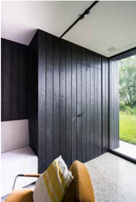
Houten wandbekleding voor een woningaanbouw in Kortrijk.
