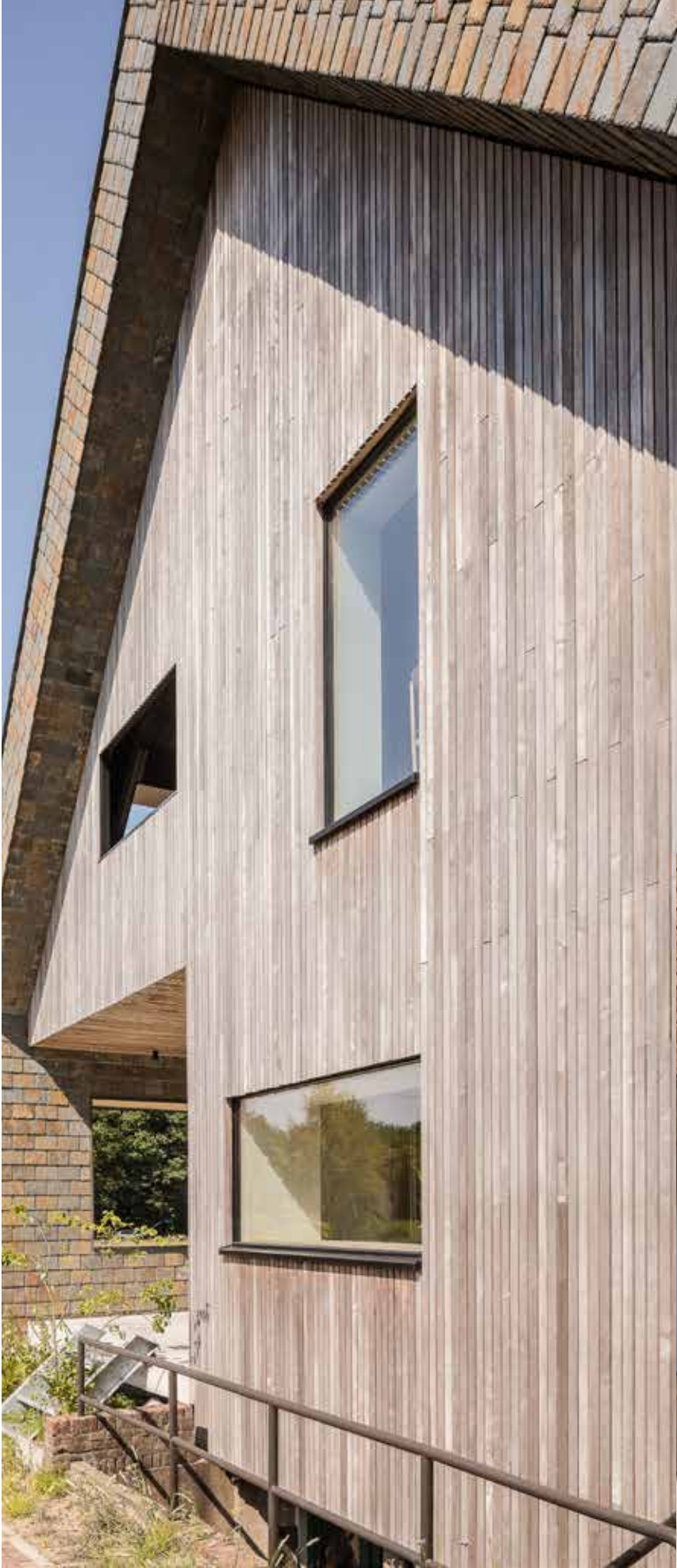
Bij de herbestemming van een bunkerboerderij naar een woning werd een gevelbekleding uit HOTwood essen toegepast. (Beeld: Elroy Spelbos, Loerbeek)
